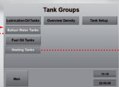
Gesamtüberblick der Tanksituation
